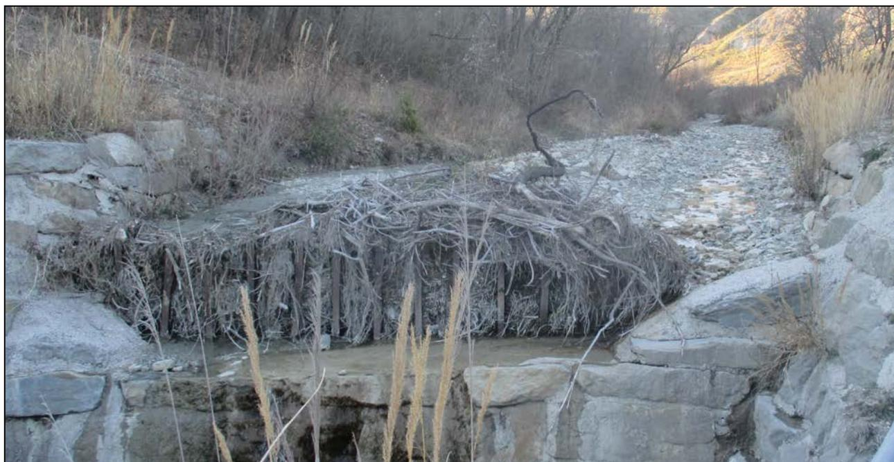
*Figura 2: seconda briglia a pettine esistente da ripulire*
