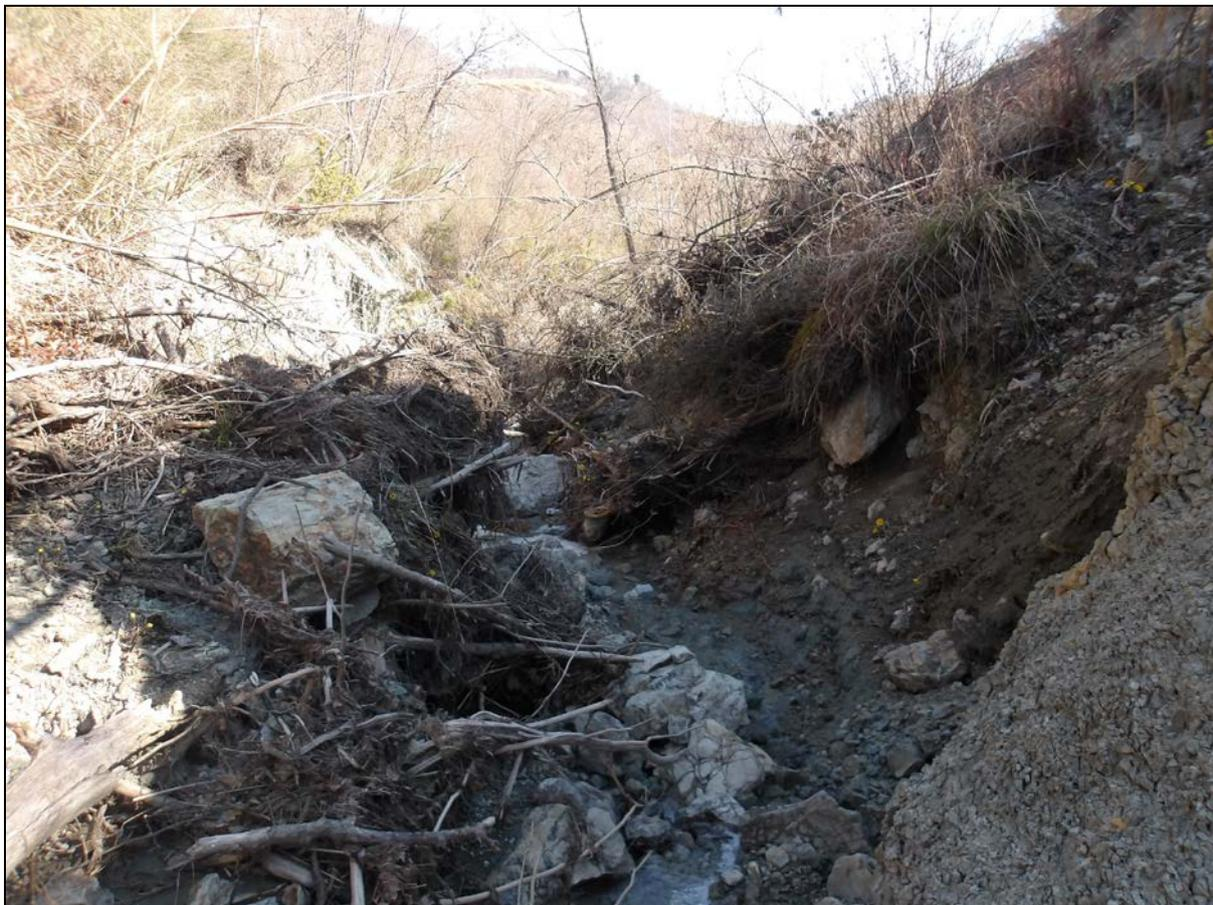
*Figura 5: eliminazione elementi di ostacolo al deflusso idrico*
