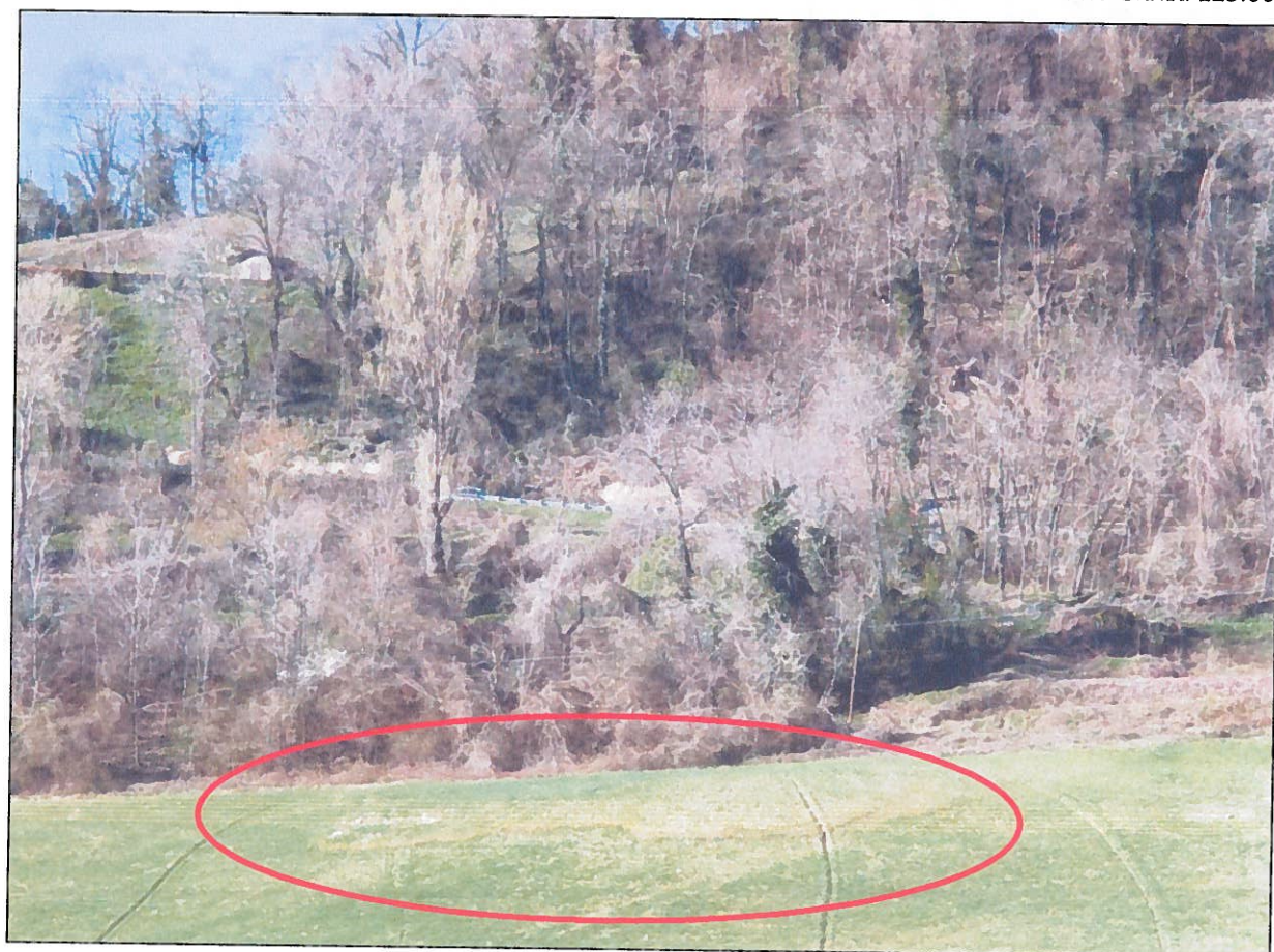
Figura 3: Vista frontale dello scorrimento, circolettata l'unghia di frana
