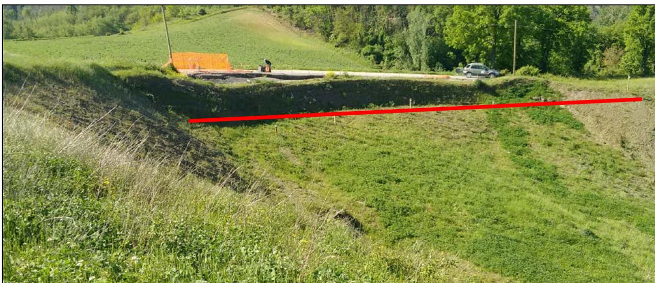
Figura 26: vista frontale delle terre rinforzate al 10/05/2019, in rosso la direttrice di pendenza della base dello scavo necessario ad "asciugare" il rilevato
