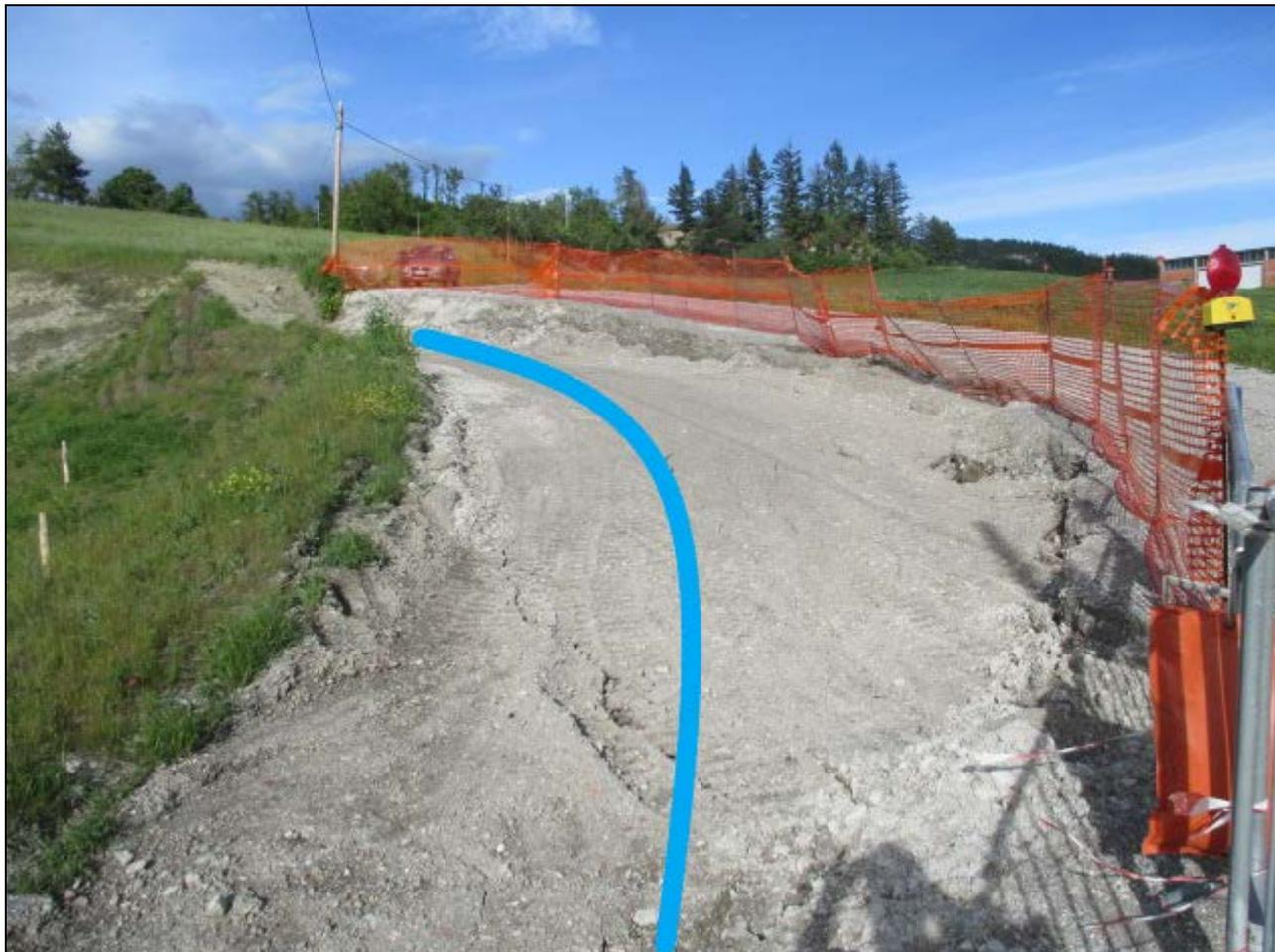
Figura 25: Stato al 20/05/2019 del cedimento della sede stradale. In blu la line del tracciato del drenaggio da realizzare
