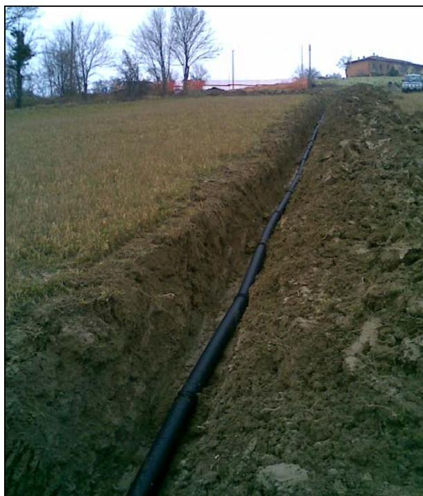
Figura 24: Estratto della Relazione del Progetto iniziale, figure 5.1a e 5.1b: pozzetto posto lungo la cunetta stradale (5.1a) e condotta di scarico interrata verso il Rio Ranocchio sul versante opposto (5.1b). Fotografie risalenti al gennaio 2014
