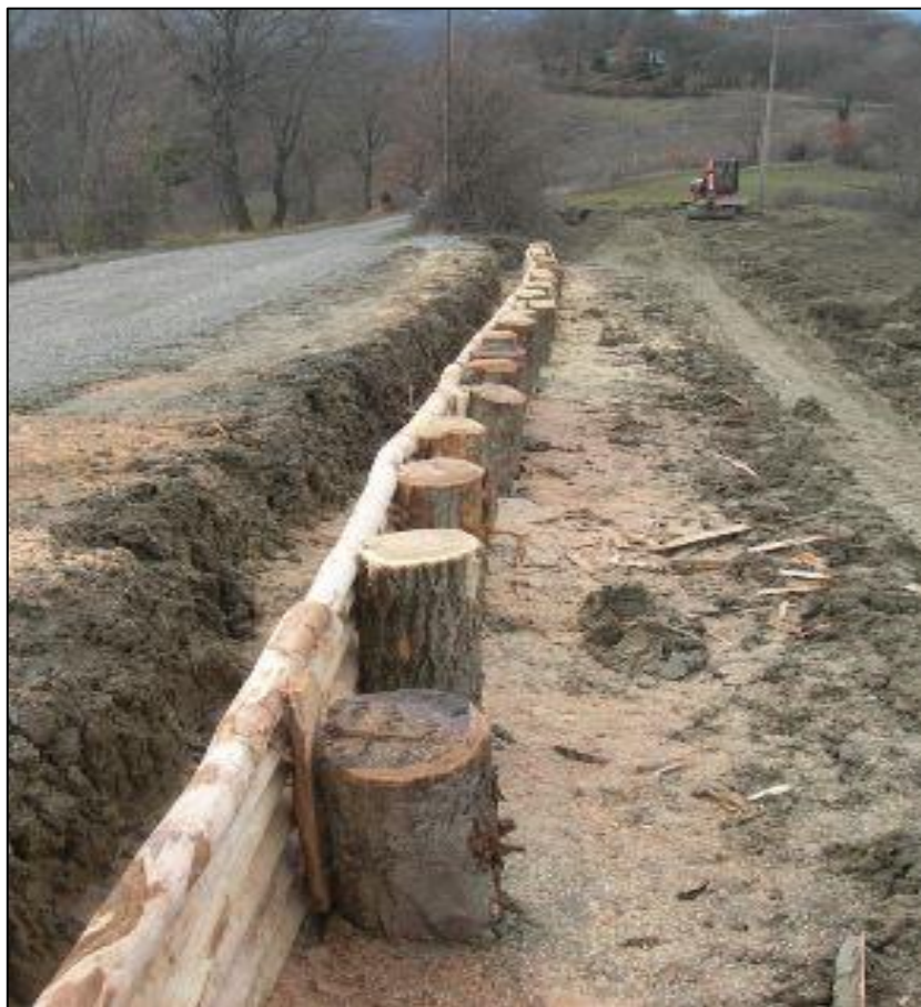
Figura 8: palificata costituita da 20 pali di castagno pre-trivellati.
