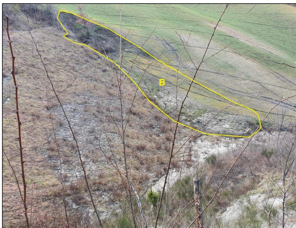
Figura 29: Foto panoramica della frana B. Il contorno in giallo è il perimetro della frana.
