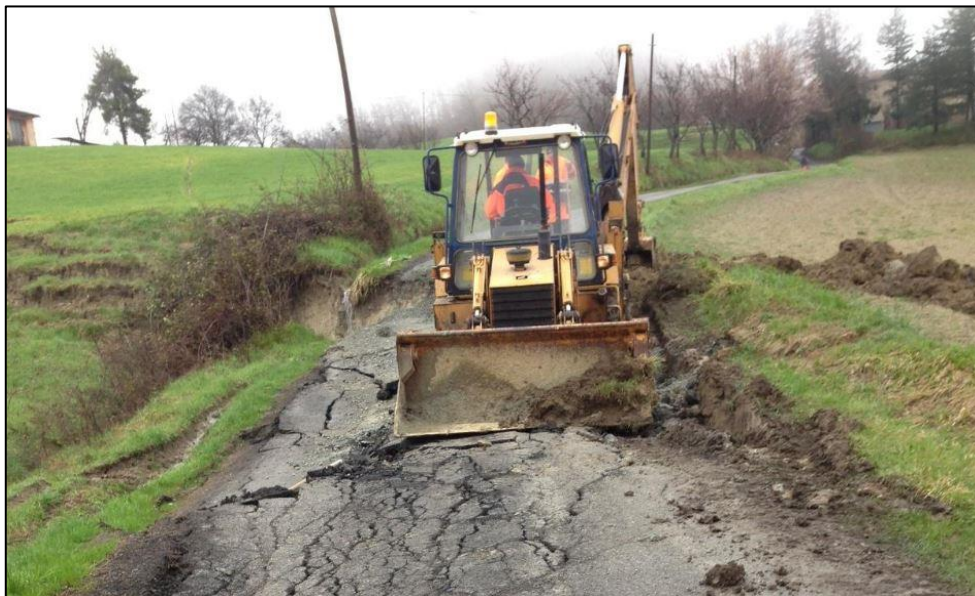
Figura 4: Abbassamento strada. Foto del 07/04/2013.
