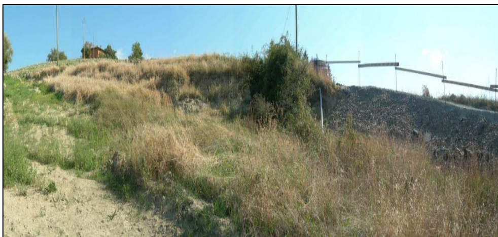
Figura 5: Abbassamento strada. Foto del 26/09/2013.
