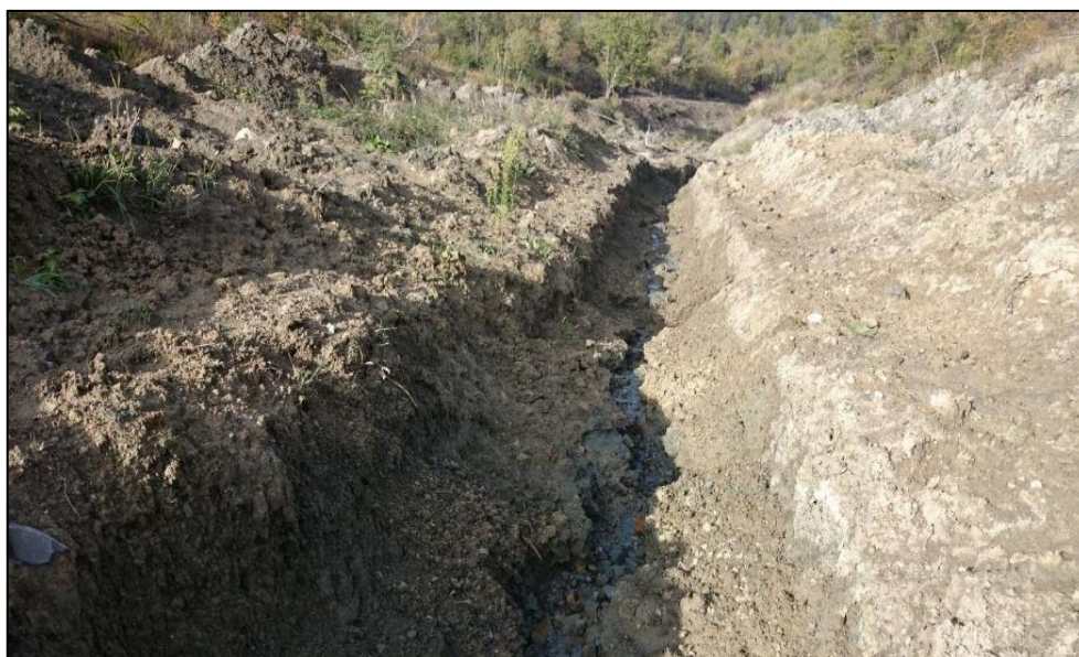
Figura 11: Lavori per la creazione dei fossi a valle del corpo di frana con scarico finale nel Rio Dozza, realizzati da Agricoop nel giugno-luglio 2015.
