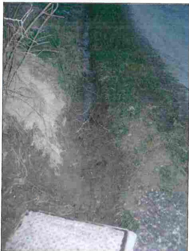
Figure 15: cunetta stradale a sx e condotta di scarico interrata verso il Rio Ranocchio su versante opposto a dx
