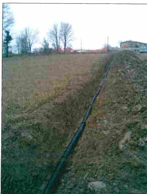
Figure 15: cunetta stradale a sx e condotta di scarico interrata verso il Rio Ranocchio su versante opposto a dx
