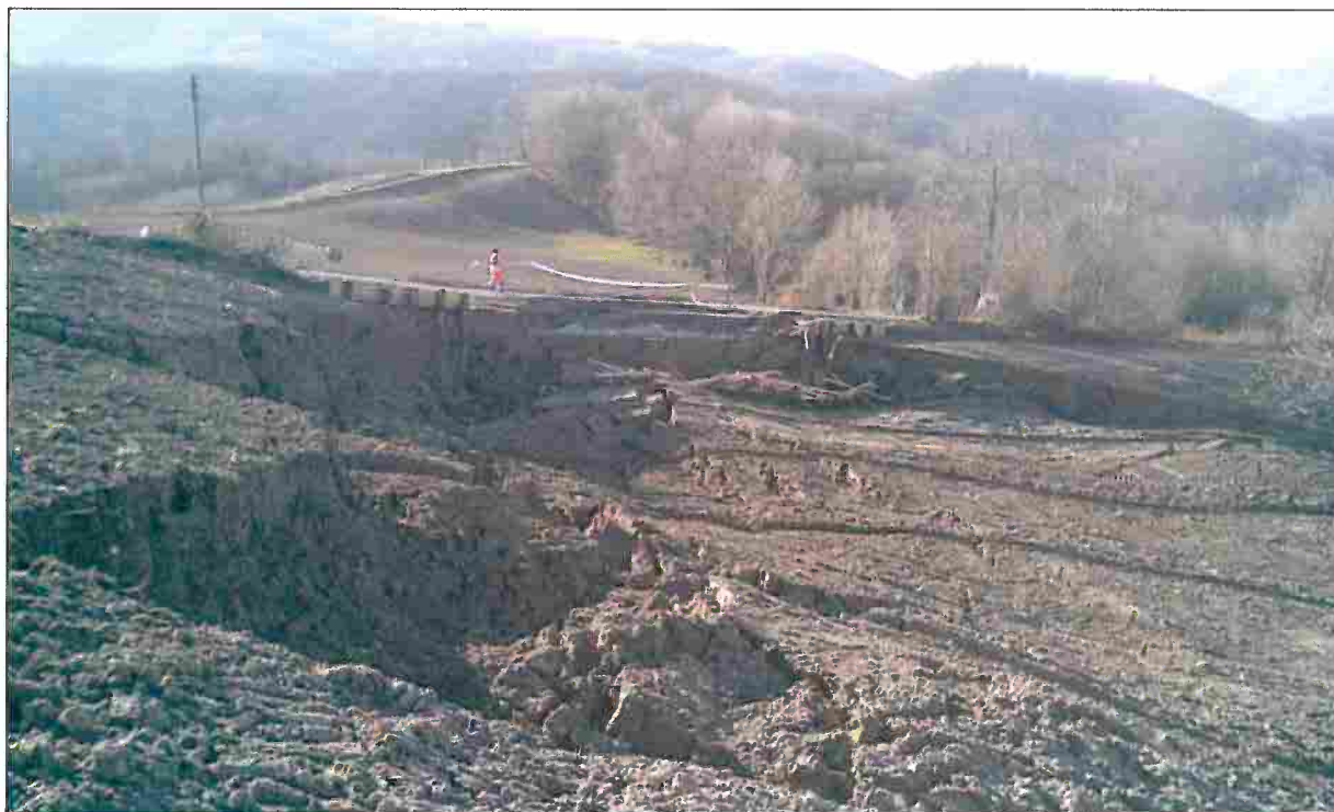
Figura 8 – Stato della scarpata principale al 26/01/2014
