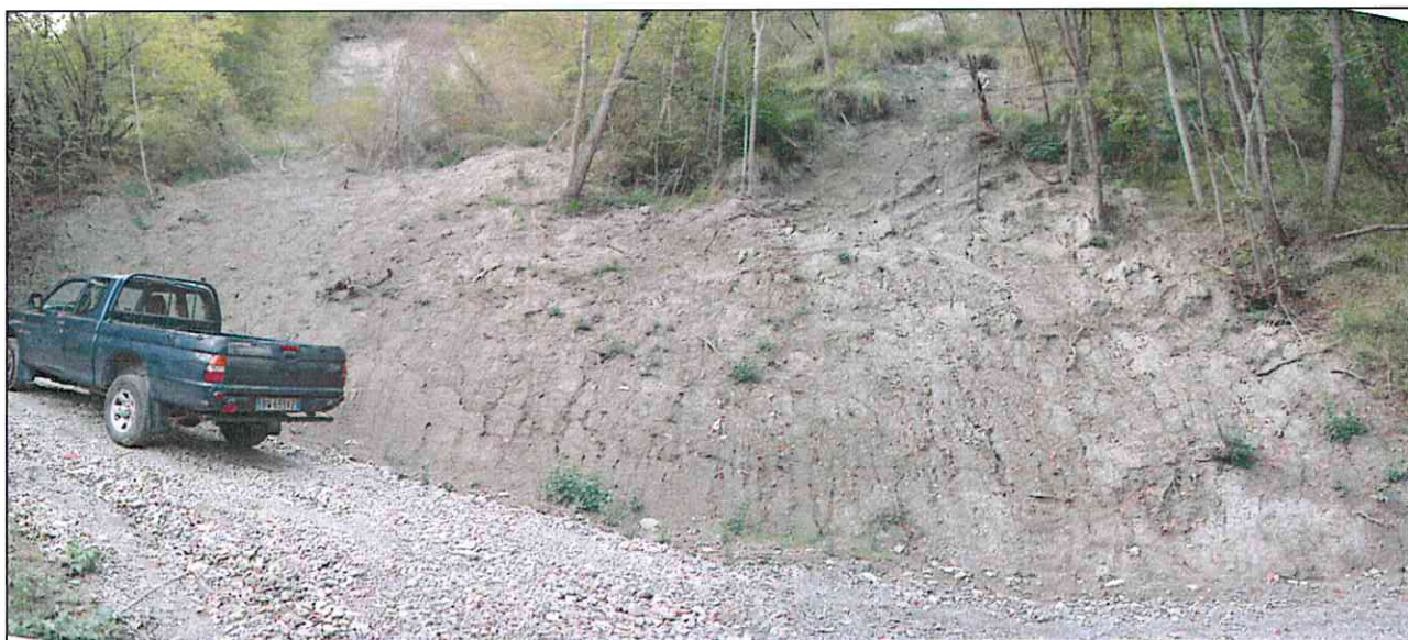
Figura 7 – tratto in esame visto da valle
