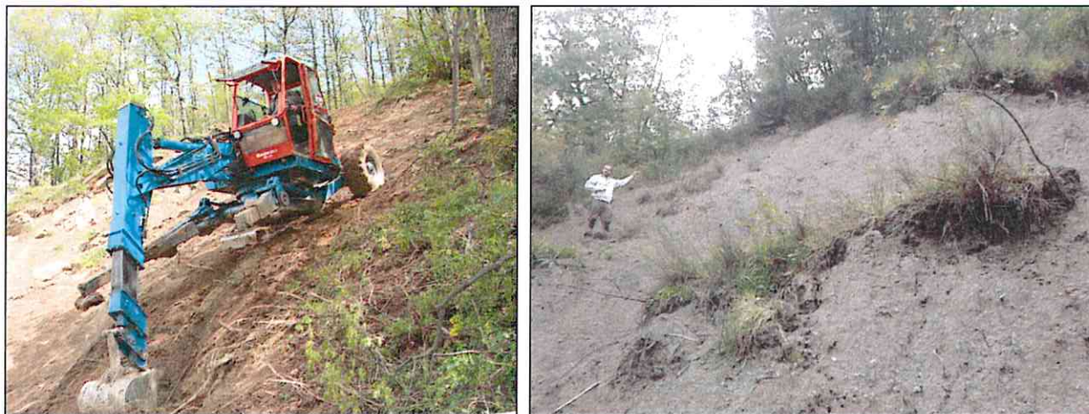
Figura 8 – escavatore tipo “ragno” e particolare della zona di distacco da riprofilare
