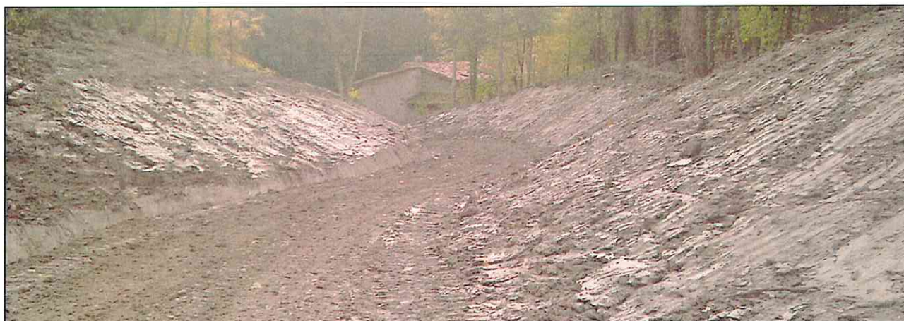
Figura 6 – Riprofilatura del deposito per colamento di fango su Via della Valle in loc. Molinelli
